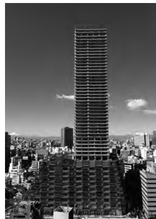
■ COVER PHOTO ■ 豊島区役所新庁舎
